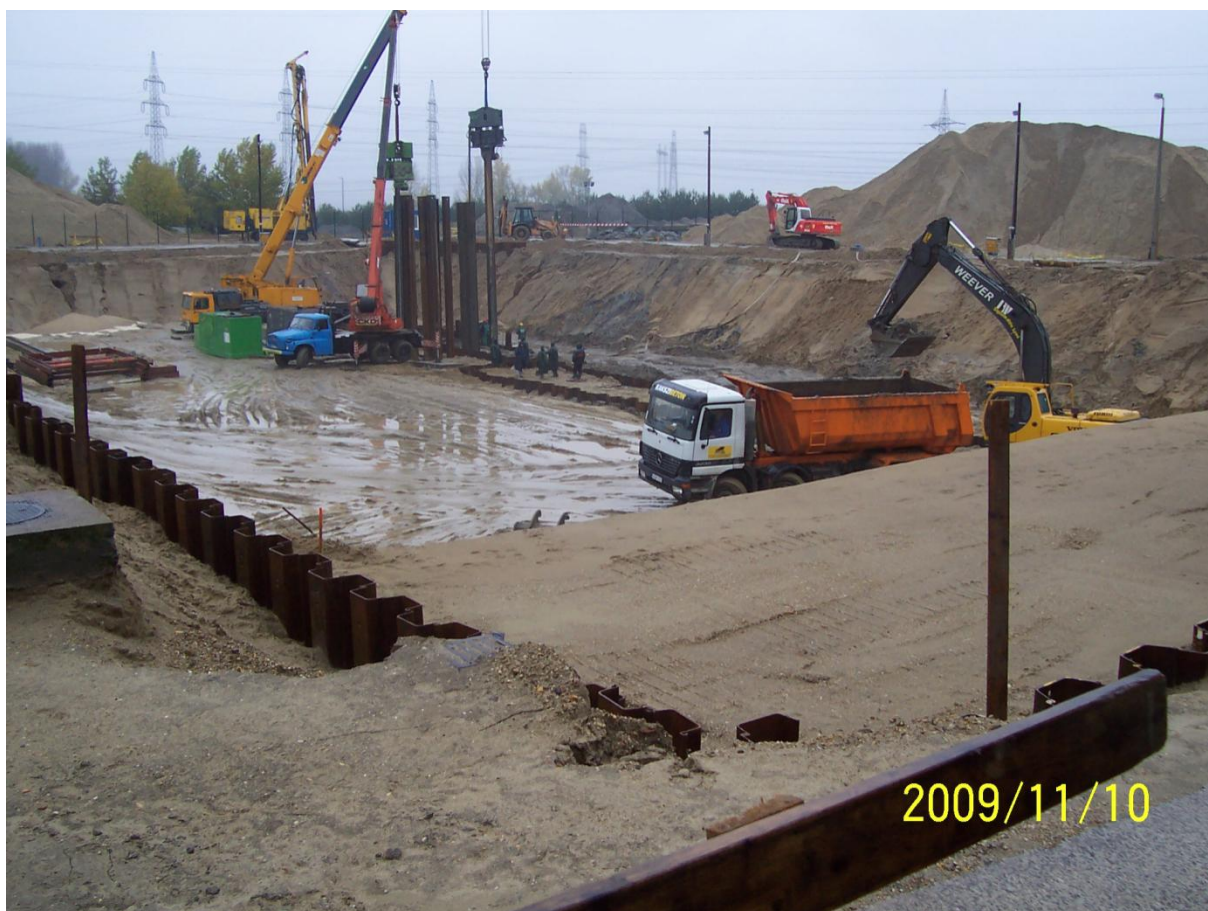
1.2-1. kép: A III. ütem 1. fázis építésének alapozási munkái
